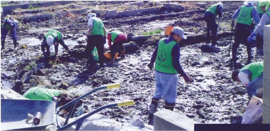
大槌町、泥の中のがれき撤去
